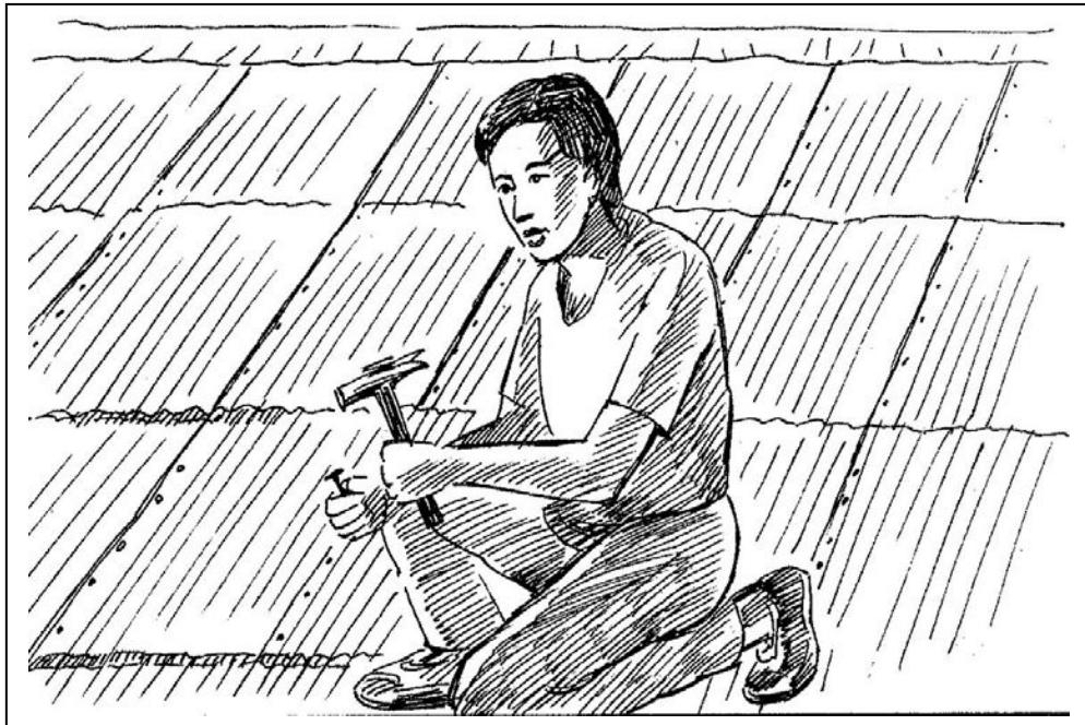
รูปที่ 33-2 ตรวจตรา และทำการซ่อมแซมหลังคาบ้าน อย่างสม่ำเสมอ
